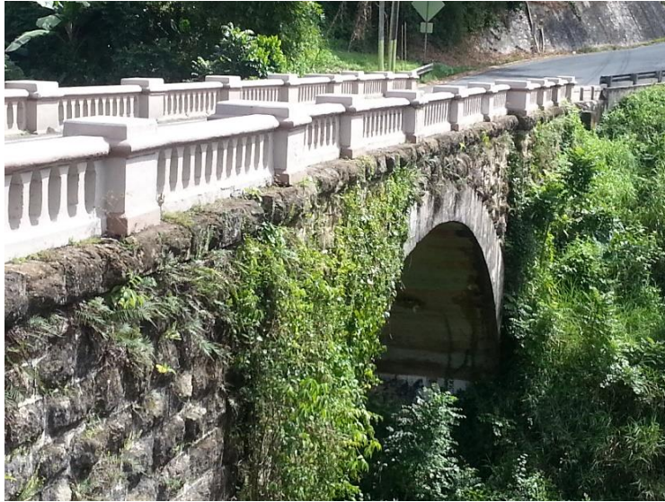
Fotos: 2 Puente Mavillas, Foto: CTorres
